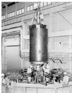
超伝導コイルの据付
